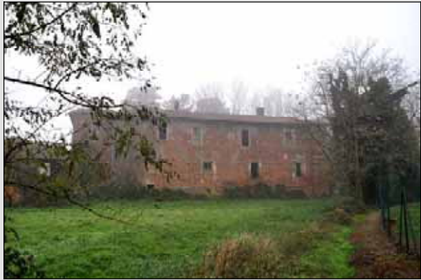
Figura 65 Castello 2011: facciata est
