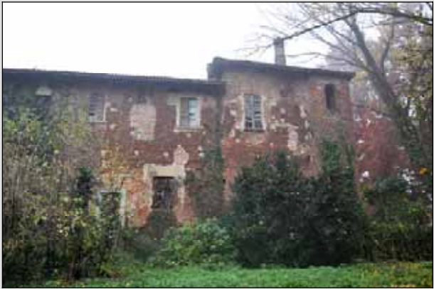
Figura 66 Castello 2011: facciata sud ovest
