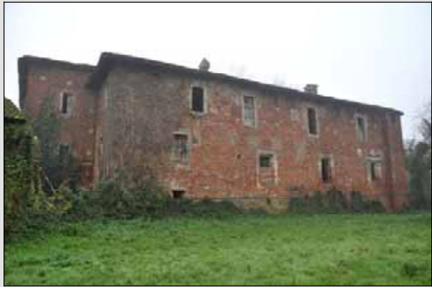
Figura 67 Castello 2011: facciata est
