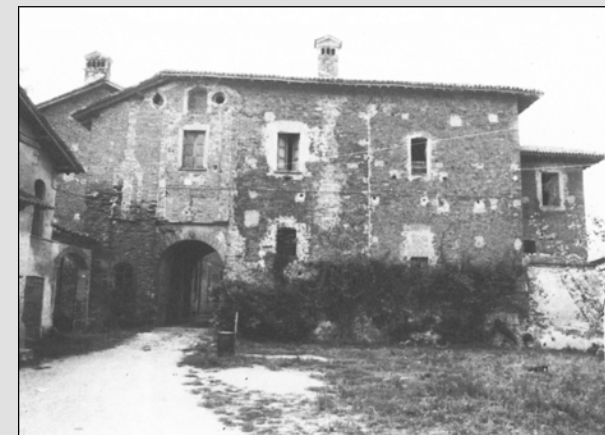
Figura 55 Castello: facciata est
